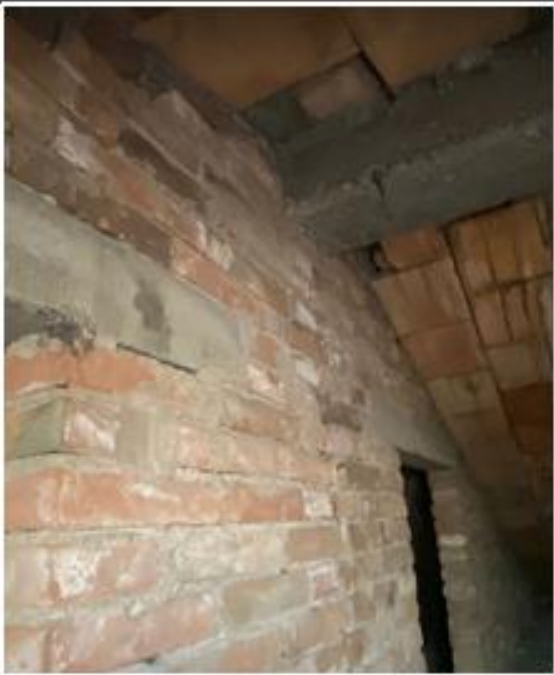
SOTTOSTRUTTURA IN LATEROCEMENTO
